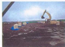
改良材散布作業
